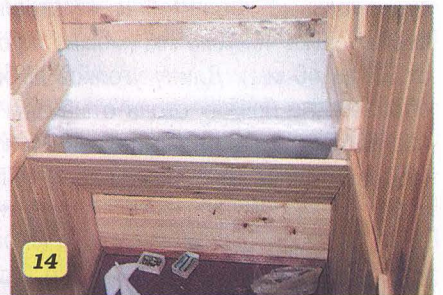
14 Завершены наиболее ответственные операции по устройству стола: надежно закрыты теплоизолирующим материалом поверхности, закреплены направляющие и несущие элементы подоконника. Теперь можно закончить обшивку ниши вагонкой, установить подоконник и уложить выдвижной щит.
