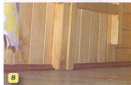
8 Чтобы опоры плотно примыкали к стене, вырезан небольшой фрагмент плинтуса.
