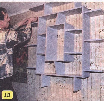
Установка верхнего модуля. Со стороны открытых створов ячеек работать удобно.
