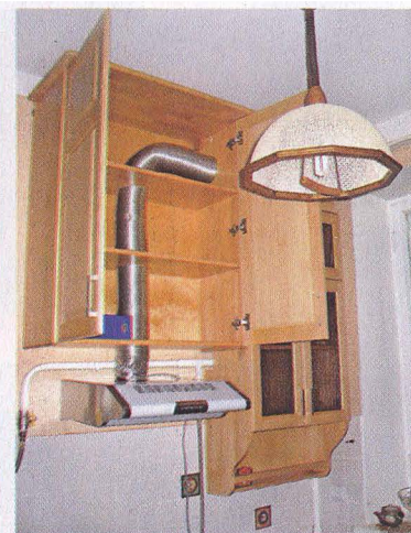
Дверки левого шкафа — глухие филёнчатые, поскольку за ними скрыт воздуховод и газовая труба.
